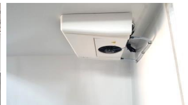
Detail stropu s integrovaným světlem a chladícím agregátem
