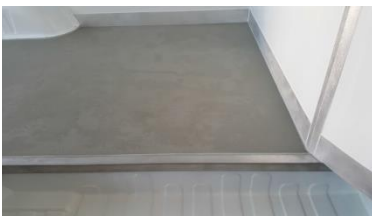
Protiskluzová podlaha s hliníkovými ochrannými lištami
